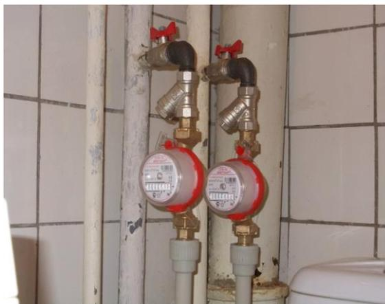
Рис.1- Счетчики воды в квартире
