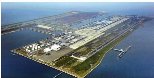
Рис.1 Аэропорт Кансай в г. Осака, Япония
