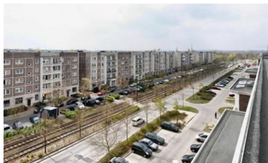
Рис. 1 – Конрад-Вольф-Аллея до реконструкции
