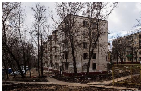
Рис. 7 – Дом до реконструкции
