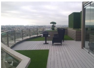
Рис. 4 – Металлическое ограждение эксплуатируемой крыши (Источник: https://lidernsm.ru )
