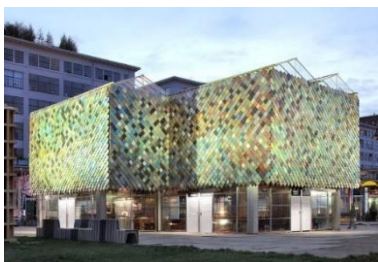
Рис. 8 – Фасад павильона из переработанного пластика (Источник: https://www.architime.ru )
