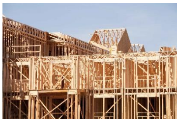
Рис. 1 – Несущие конструкции из древесины (Источник: https://www.pilomarket.ru )
