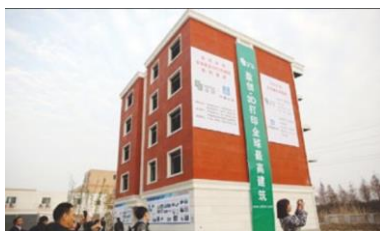
Рис. 2 – Пятиэтажный жилой дом, собранный из предварительно напечатанных элементов
