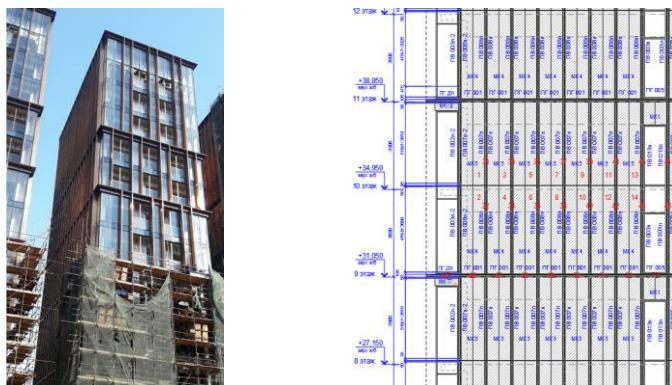
Рис. 4 – Пример формирования и реализации организационно-технологических решений по устройству фасадной системы (НВФ)
