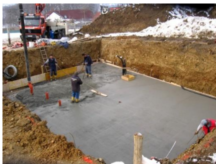
Рис. 4 – Строительство фундамента
