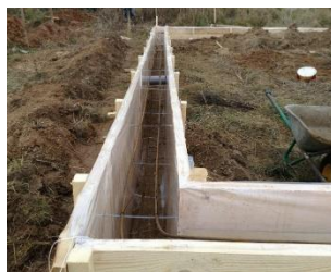
Рис. 2 – Строительство ленточного фундамента
