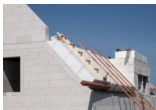
Рис. 3 – Пример сплошной кровли из газобетонных плит
