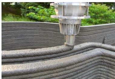
Рис. 1 – Внешний вид стены, напечатанной строительным принтером
