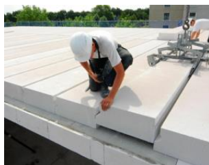
Рис. 4 – Применение газобетонных плит перекрытия
