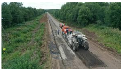
Рис. 2 – Холодный ресайклинг существующего покрытия автомобильной дороги
