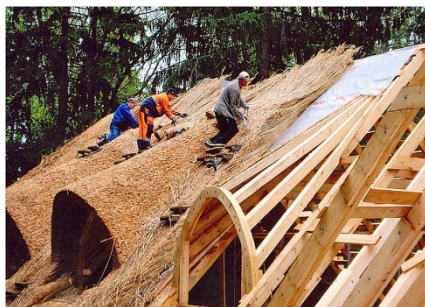
Рис. 3 Монтаж кровли из тростника
