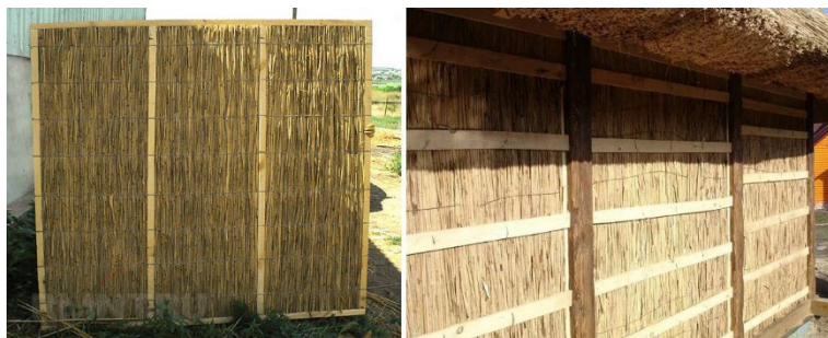
Рис. 2 Камышитовая плита в деревянном каркасе
