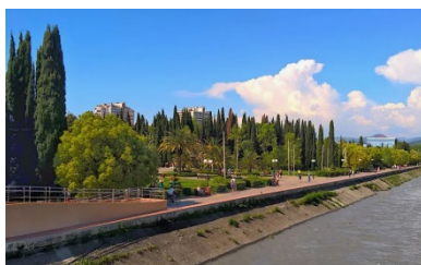
Рис. 1. Укрепление волноотбойной бетонной стеной. Набережная р. Мзымта [3]
