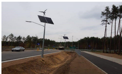
Рис 4 Автономные комплексы искусственного освещения автомобильных дорог
