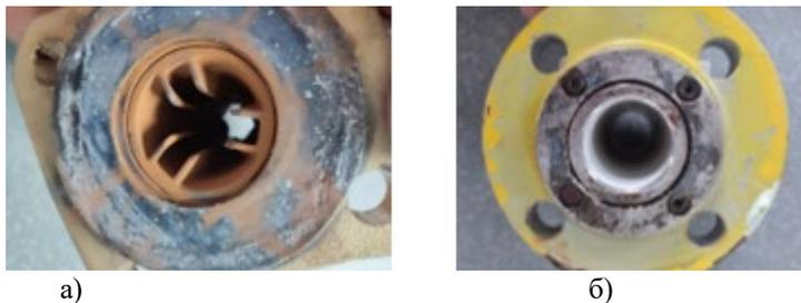
Рис. 1. Узлы учета водоснабжения до очистки (а) и после (б)
