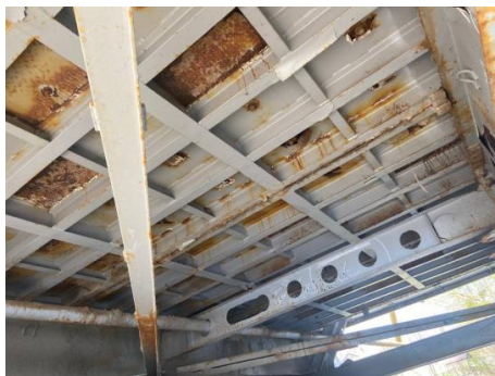
Рис. 2. Местная коррозия
