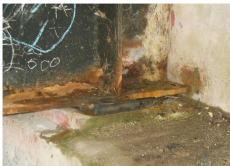
Рис. 3. Язвенная коррозия
