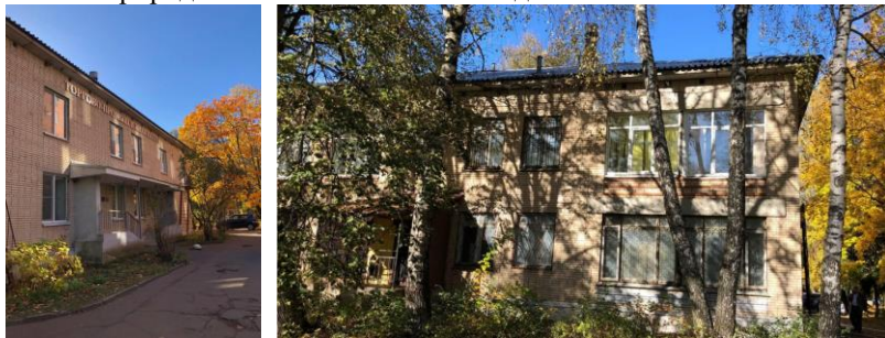
Рис. 1 Исследуемый объект: нежилое здание, г. Обнинск
