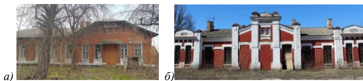
Рис. 1. - Железнодорожные станции Белгородской области: а) станция Зинаидино, б) станция Юсупово.
