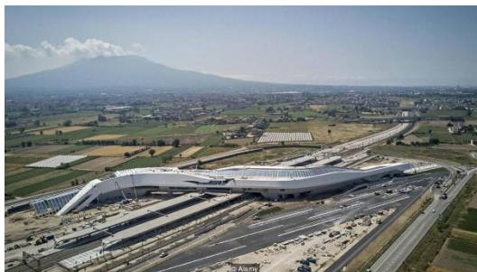
Рис.2. - Станция Афрагола возле Неаполя
