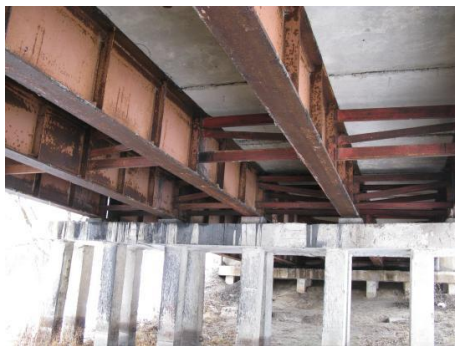
Рис. 1. Сплошная коррозия
