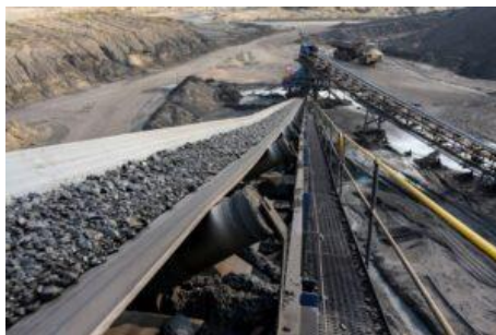
Рис. 1. Ленточный конвейер 2Л-120. (Вулкан, Мозамбике)
