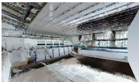
Рис. 2. Облако точек трехмерного лазерного сканирования бассейна
